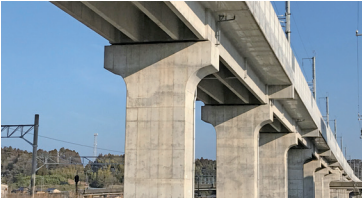
コンクリート構造物の長寿命化修繕計画策定に向けた、非破壊での広範囲な塩分分布マッピング。
