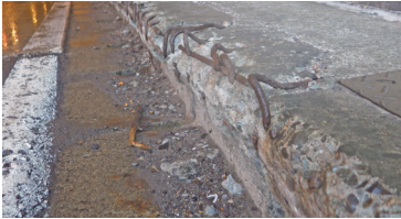
寒冷地等の道路擁壁・床版における、除雪剤（凍結防止剤）散布エリアの塩分浸透状況の広域調査。
