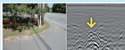
電柱から建物まで伸びる埋設管
